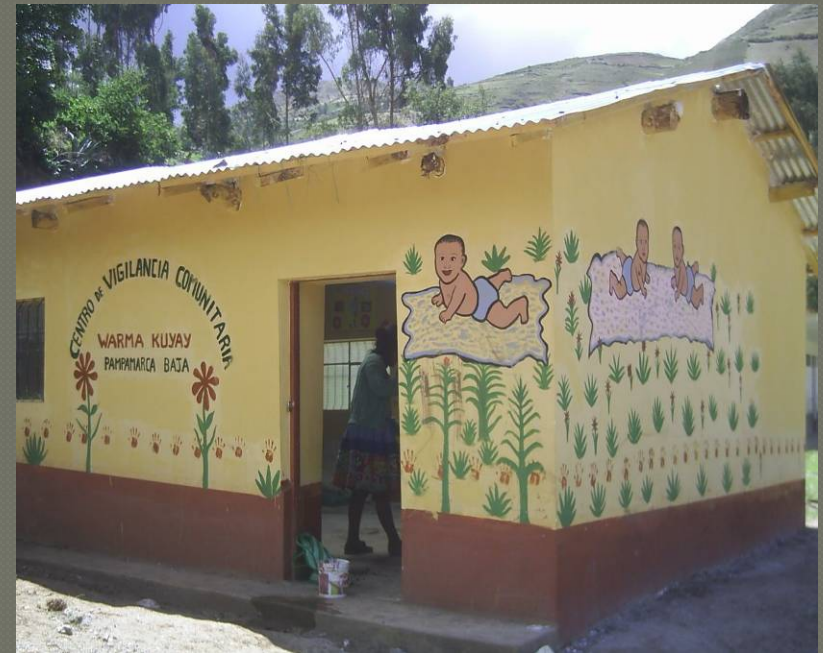
CENTRO DE VIGILANCIA COMUNAL DE TARAMBA
